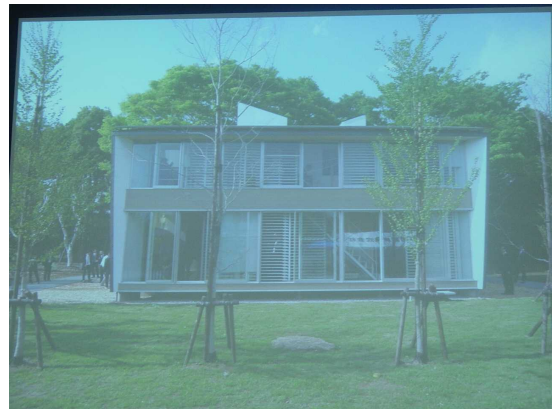
筑波の LCC マイナス実験住宅 （太陽光パネル 8kw/h、太陽熱給湯他）
